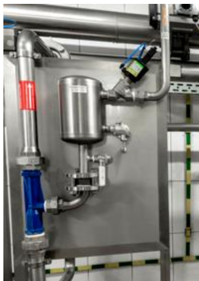
Separator ozonu do układów wprowadzania ozonu do wody
