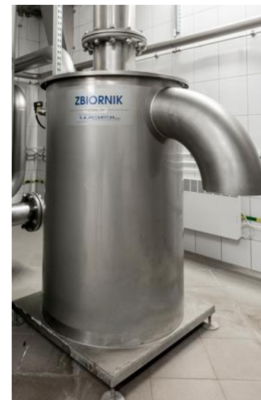
System odgazowania z pułapką wodną
