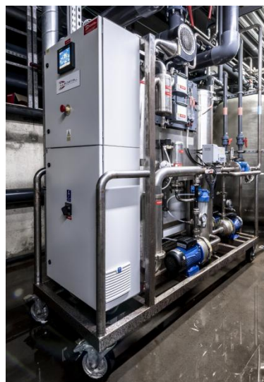
SPID Serii Blue do produkcji wody wysoko-ozonowanej 4 m 3 /h
